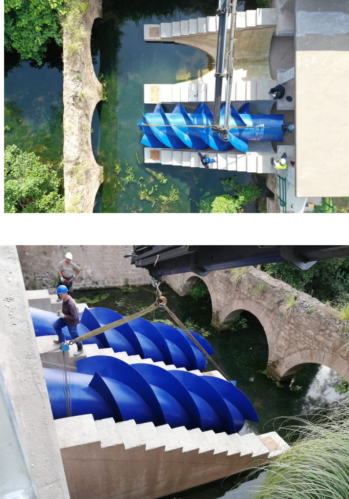
Fig. 6. Instalación de las turbinas tipo tornillo de Arquímedes instaladas en obra.
