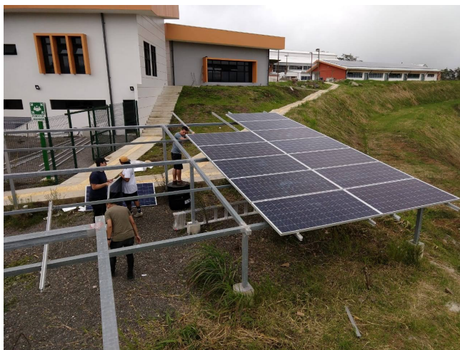
Figura 6. Trabajos en instalación sobre piso
