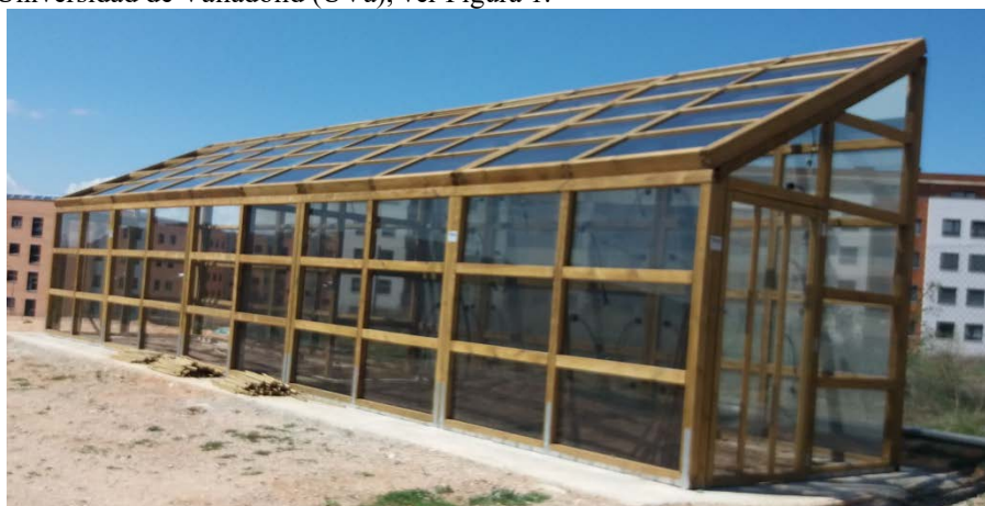
Fig. 1. Vista general del prototipo “Invernadero Fotovoltaico-es”. La mitad izquierda es con vidrio convencional y la derecha con vidrio fotovoltaico de silicio amorfo.
