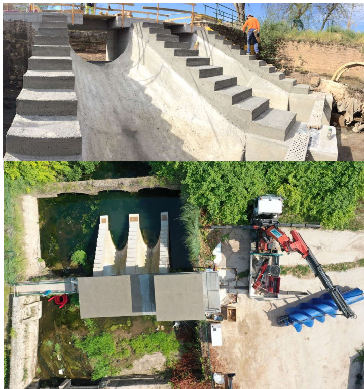
Fig. 5. Ejecución obra civil cauce Solvay.
