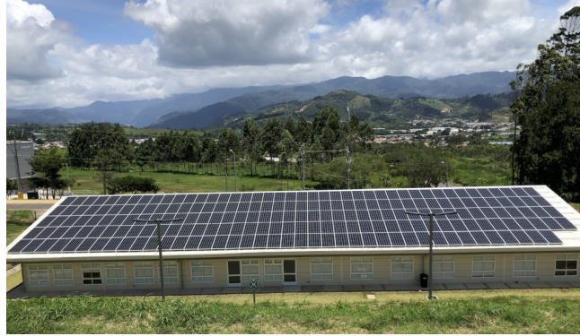
Figura 4. Vista sistema se fotovoltaico sobre edificio de Fundación Tecnológica
