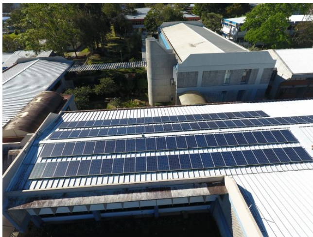
Figura 1. Vista aérea planta fotovoltaica edificio de Rectoría
