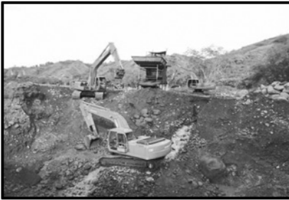
a) Remoción de cobertura vegetal
