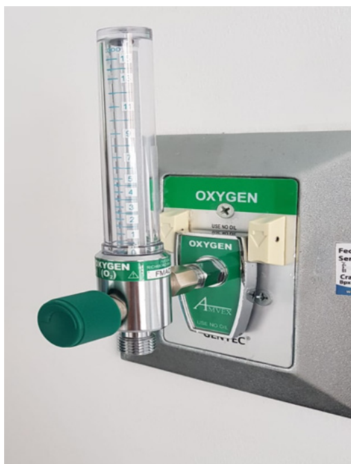
Figura 96. Flujómetro.
