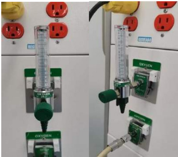
Figura 101. Flujómetro conectado a oxígeno de pared.
