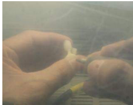
Ilustración 187. Eliminación del revestimiento con perlas de brillo a presión.
