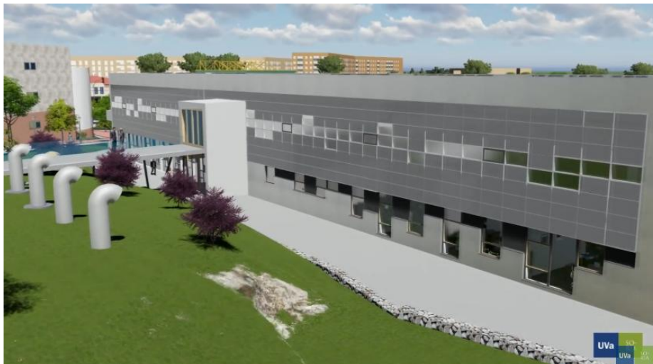
Fig. 4. Bocas de entrada a los tubos geotérmicos en la ladera. Fachada orientación SO.
