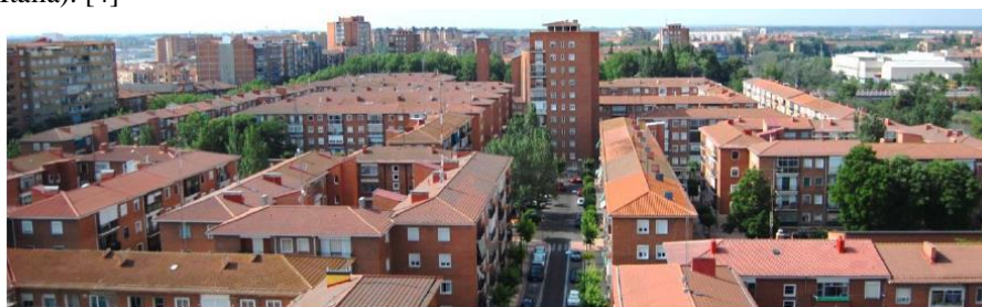
Fig. 2. Vista aérea del distrito 4 de Marzo en Valladolid
