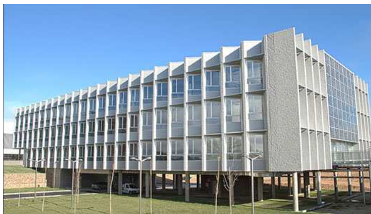
Fig. 4.- Vista de la zona de aparcamiento del edificio LUCIA
