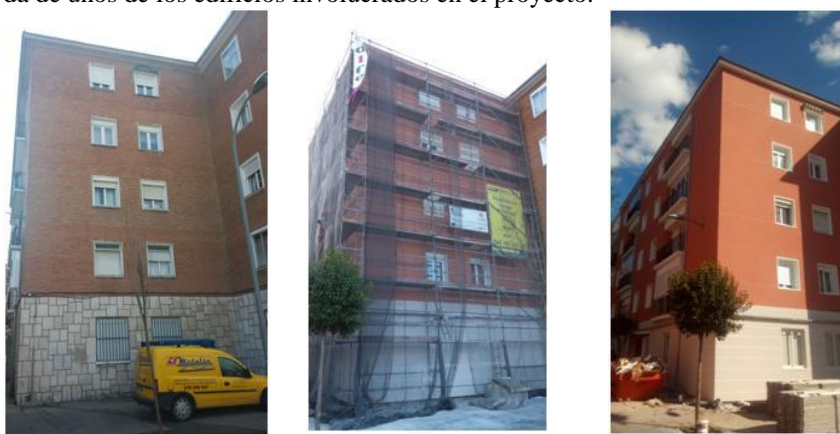
Fig. 3. Detalle de los trabajos de aislamiento térmico de la envolvente térmica
