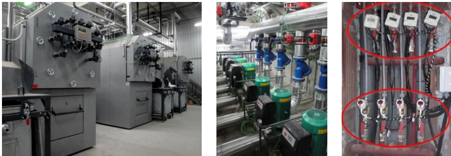
Fig. 6. Nueva central de producción con biomasa y contadores de energía térmica
