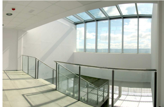
Fig. 9.- Vista muro cortina cubierta
