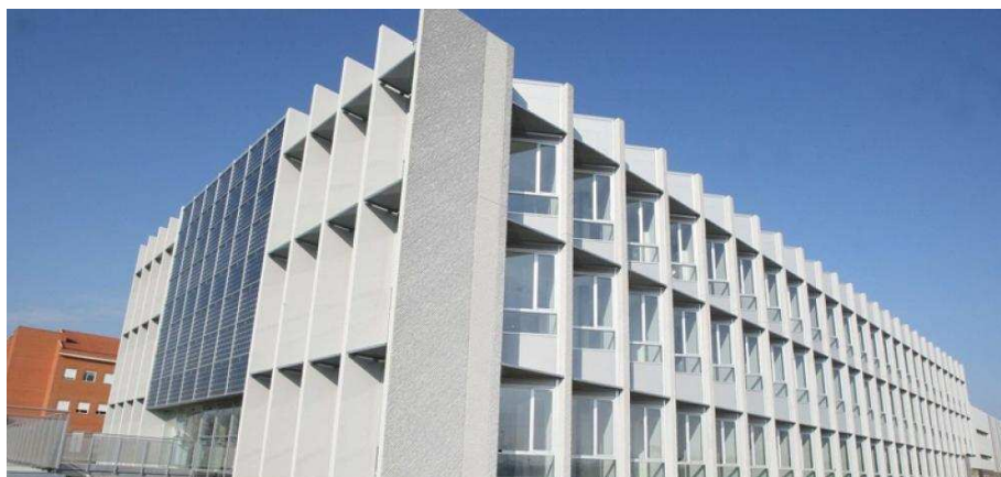
Fig. 6.- Vista de la instalación fotovoltaica fachada sur
