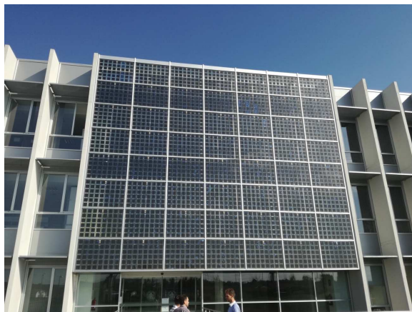
Fig. 7.- Vista frontal fachada sur
