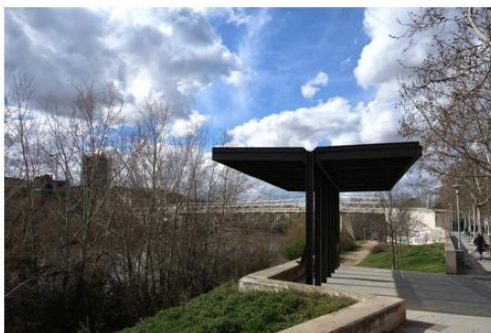
Fig. 4. Pérgola fotovoltaica para la carga de vehículo eléctrico.
