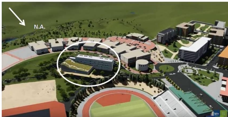
Fig. 1. El edificio (centro) en su entorno. Orientación y edificios cercanos.
