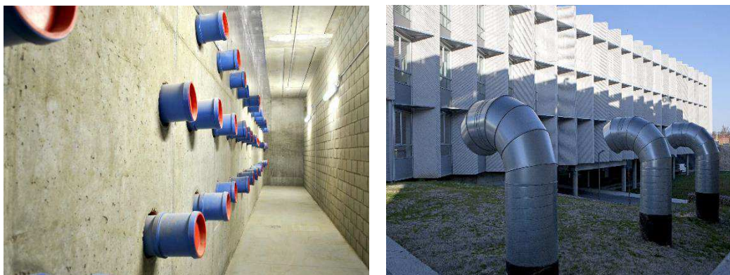
Fig. 3.- Vista de la instalación de los pozos canadienses
