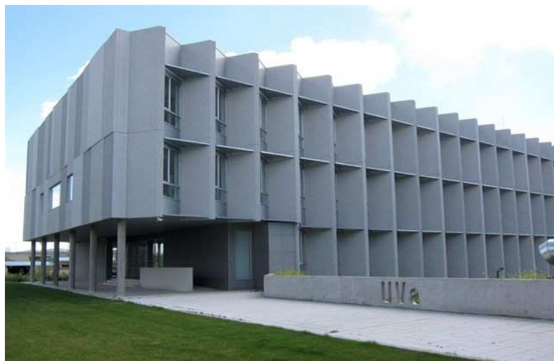
Fig. 1.- Vista general del edificio LUCIA
